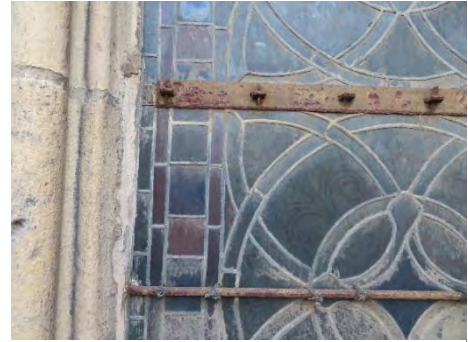
Détail des calfeutrement et armatures, baie 103, phot. P. Villeneuve mars 2020
